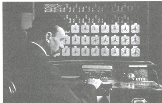
Az 1890-es népszámlálás adatait lyukkártyával rögzítették az Egyesült Államokban. A bal oldali ábrán az üzenet kódolásához használt lyukasztót látjuk egy lyukkártyával. A jobb oldali ábrán a lyukkártyaolvasó látható: ahol a tű átesik a lyukon, ott a megfelelő óra egyet lép. A népszámlálás adatait néhány hét alatt feldolgozták, a rendszer kidolgozója, Herman Hollerith [holerit] erre a szakmai és üzleti sikerre alapozva hozta létre a későbbi IBM-et [ájbiem]
